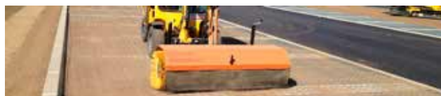
Underfyldet fremstilles ved hjælp af en fejmaskine
