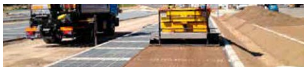
Bagfyldet anbringes med en udlægningsmaskine
