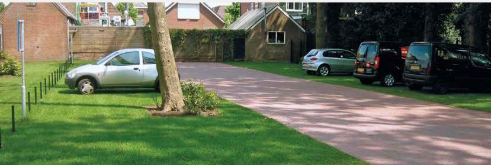
Rodnettet fra gamle værdifulde træer kan bevares og beskyttes ved at overbygge med TTE belægning
