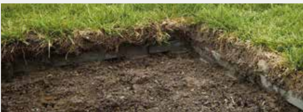
TTE®-forstærkning under græsplænen
