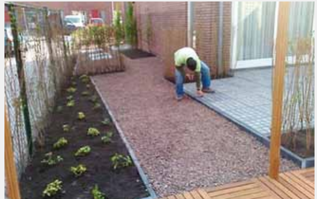
TTE®: med ralfyld, overdækket med træ og TTE®-kopsten (NL)
