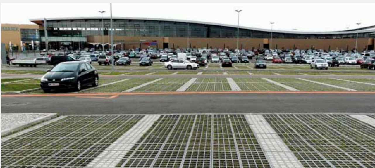
Over 22.000 m 2 personbils-parkeringspladser kort efter færdiggørelsen ved et stort indkøbscenter i nærheden af Wien (AT)
