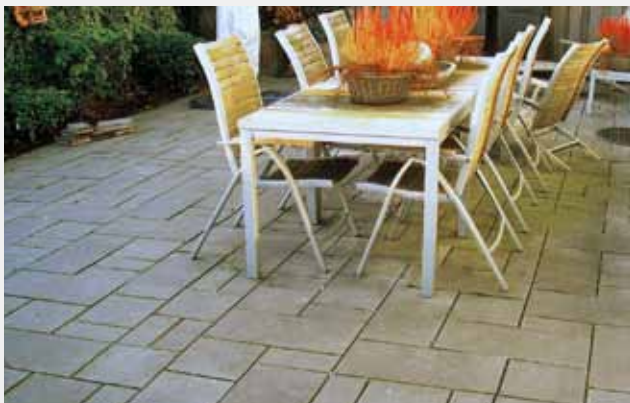
Terrassenbelægning med TTE® (DE) som bærelags erstatning
