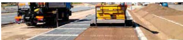
Bagfyldet anbringes med en udlægningsmaskine
